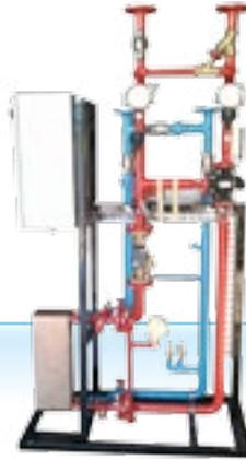
**Verticale directe** : tubes coudés à 90° vers le haut immédiatement en sortie de connexions échangeur
